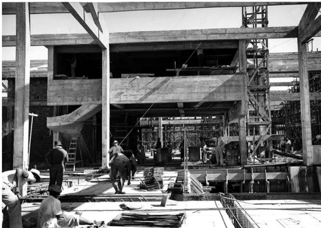
Fábrica Nacional de Motores: operários erguem o prédio da fábrica em Duque de Caxias, no Rio de Janeiro
